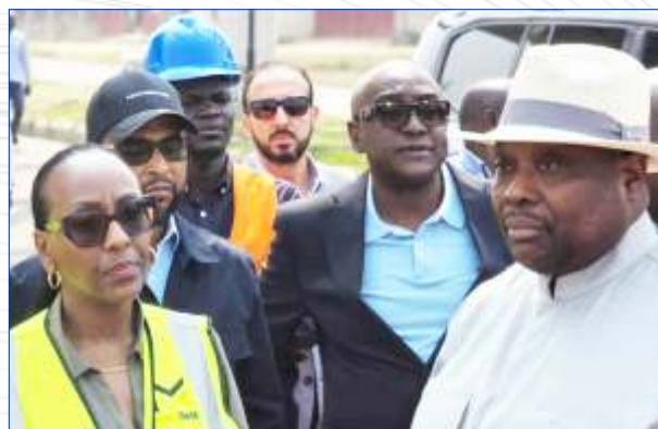
Suivi des travaux par le Ministre d'État dans la Zone Économique Spéciale d'Ignié au parc industriel de Maloukou
